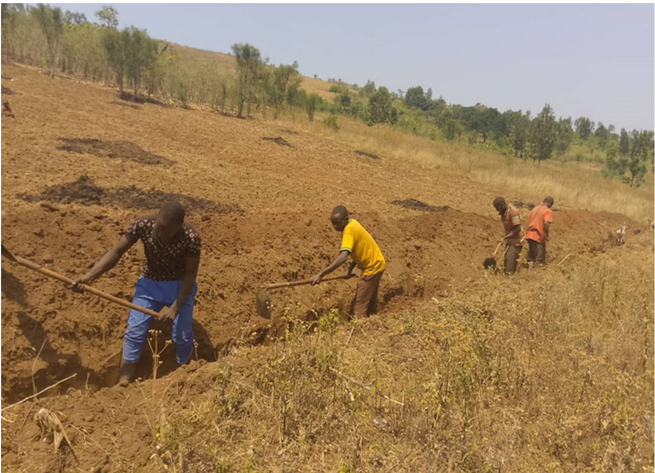
Photo 4. L'ACDC de la Colline Rukinzo en Commune Gasorwe en train de creuser des fosses antiérosives
